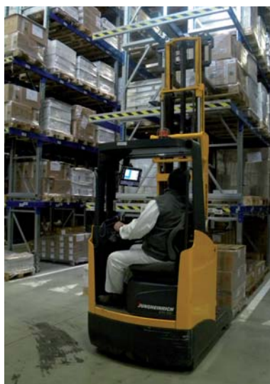
Il magazzino intensivo, della capacità di 15.000 posti pallet, ospita materiali di confezionamento e prodotti finiti. Le referenze infiammabili sono ricoverate in un'area compartimentata e dotata di impianto antincendio a schiuma
